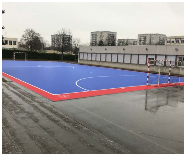
TERRAIN EXTÉRIEUR, VÉNISIEUX
